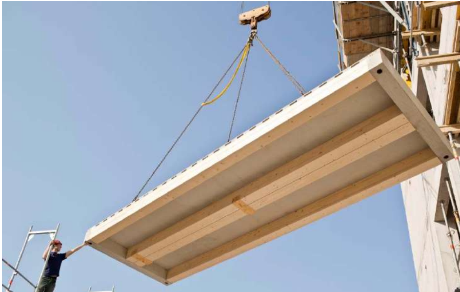
Bild I-7 Herstellung von Holz-Beton-Verbunddecken nach Option A 25
