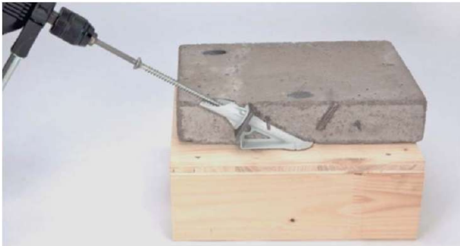
Bild I-8 Herstellung von Holz-Beton-Verbunddecken nach Option B 26
