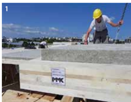
Im Pilotprojekt wurden Elemente aus fünfschichtigem BSP (14 cm) und einer 8 cm starken Betonschicht verbaut (1). Präzise auf den Grundriss produzierte XC-Elemente werden mit einem Kran eingehoben (2). Die 22 cm starken Decken vereinen die Vorteile von Holz und Beton (3)
