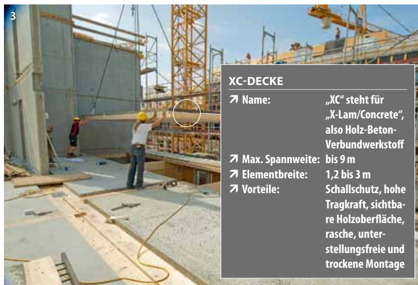
Im Pilotprojekt wurden Elemente aus fünfschichtigem BSP (14 cm) und einer 8 cm starken Betonschicht verbaut (1). Präzise auf den Grundriss produzierte XC-Elemente werden mit einem Kran eingehoben (2). Die 22 cm starken Decken vereinen die Vorteile von Holz und Beton (3)
