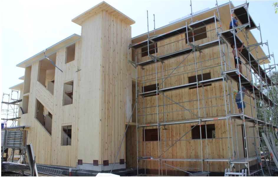
Bild I-9 Nordwestseitige Ansicht des Wohnobjektes 41
