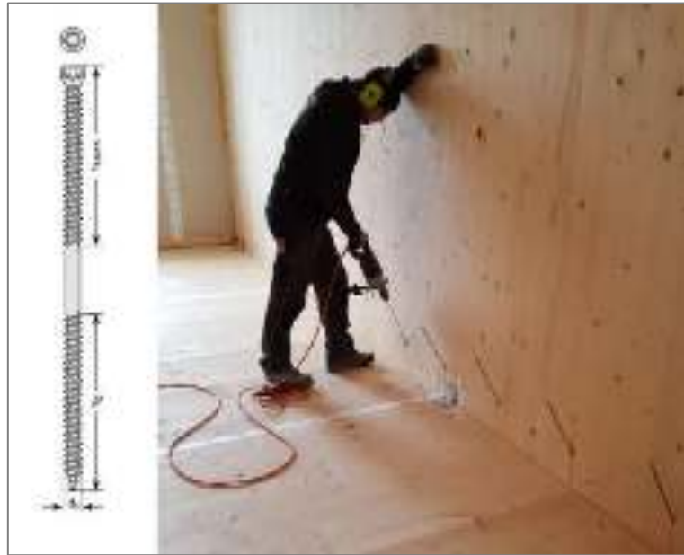
Bild I-5 Abbildung 1. Schraubverbindung VS2 15
