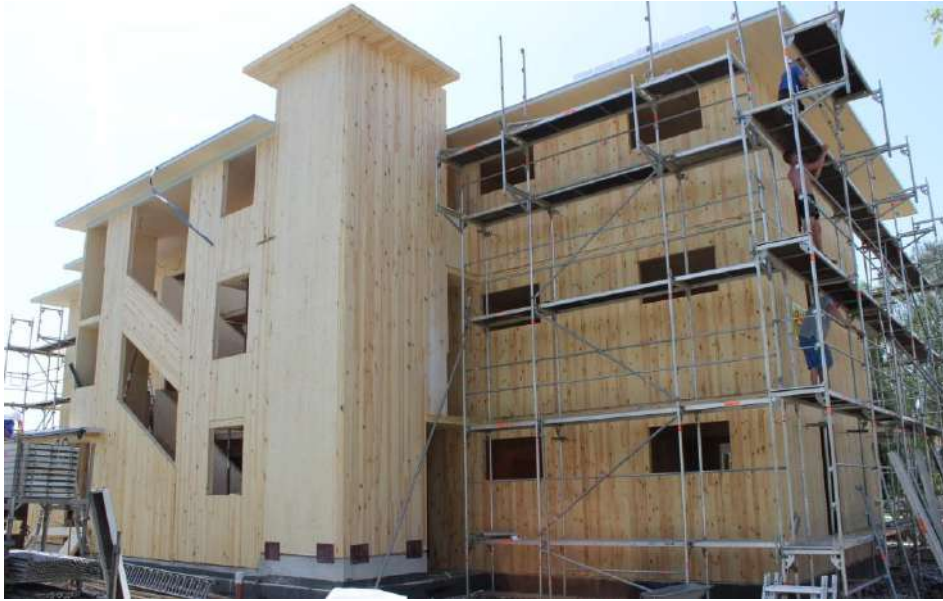
Bild I-9 Nordwestseitige Ansicht des Wohnobjektes 41
